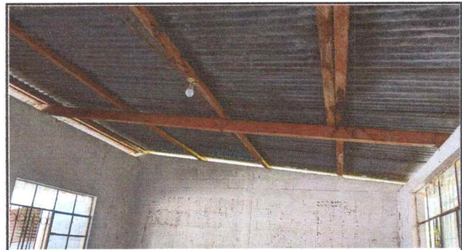
Foto 4: SE OBSERVA EL DETERIORO DE LAS TIJERAS Y COSTANERAS, MODELO #2
